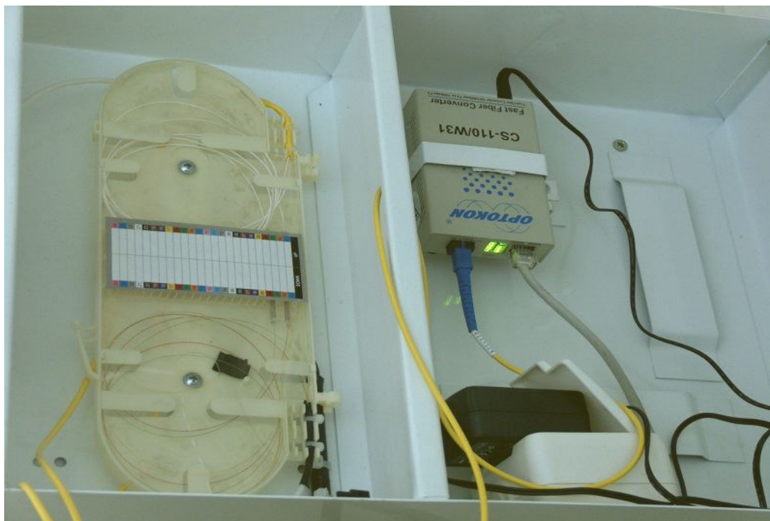
Фиг. У05-5. Връзка между стъкленото оптическо влакно и patch кордата, в дясно – медиа-конвертора
